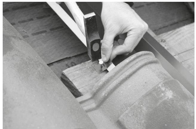
Fig. 15 Fixer le canal latéral gauche avec des languettes de fixation clouées dans les planches ou les liteaux. Ne fixez pas les couloirs latéraux dans la planche A pour ne pas créer d'écoulements en dévers dans le toit.
