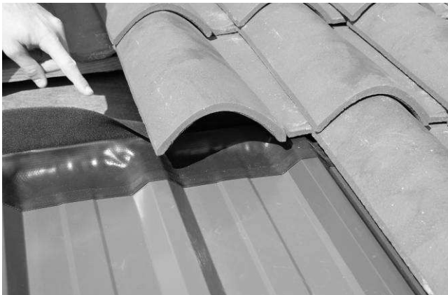
Fig. 26 Terminez alors l'étanchéité en repositionnant les tuiles autour des bacs acier du kit InterPV. Celles-ci doivent être collées sur les couloirs, entre elles et avec d'autres tuiles. La mousse anti-neige ne doit en aucun cas être pliée vers l'intérieur de la toiture pour ne pas y conduire d'eau.
