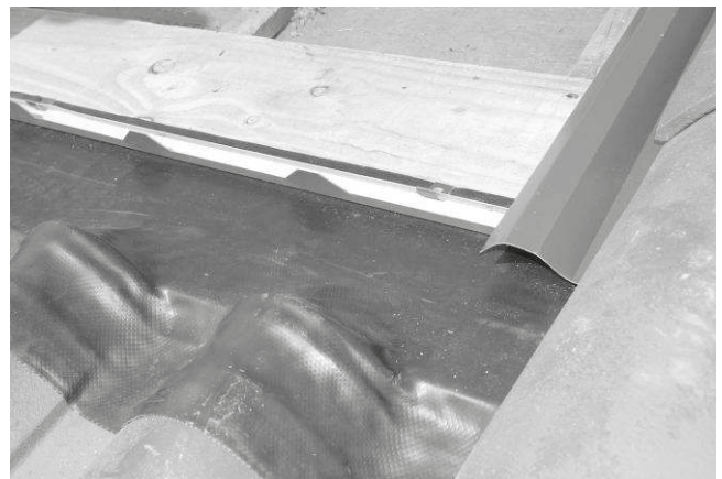
Fig. 17 Installez les couloirs inférieurs côte-à-côte (2mm de jeu) jusqu'à atteindre le nombre de sommets d'ondes total de votre kit InterPV 2010. Coupez le dernier couloir 75 mm après la dernière onde.
