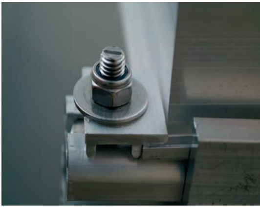
Fig. 29 Fixation latéral du capteur Optisun sur les rails.
