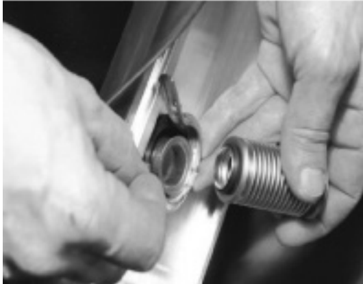
Fig. 30 Montage des raccords intercapteur. Positionnez le flexible annelé et serrer le à l'aide du collier fourni. Attention à ne pas oublier le joint torique.
