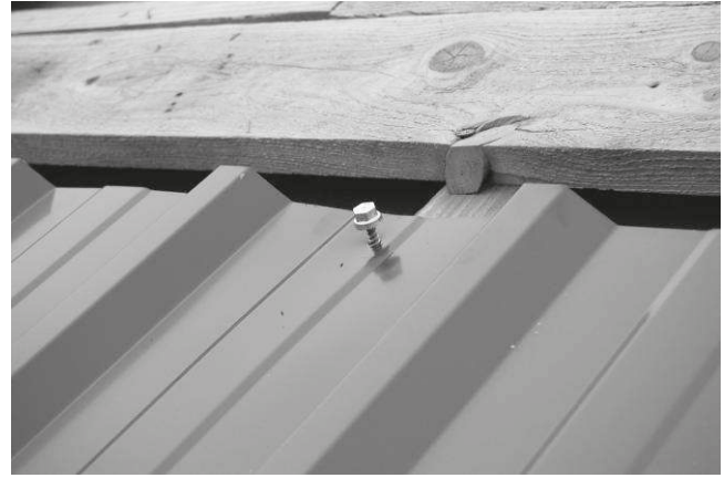
Fig. 19 En cas de nécessité (forte pente de toit, vent...), vous pouvez fixer provisoirement les bacs acier InterPV posés en utilisant une vis autoforeuse dans les 2 cm du haut du bac.
