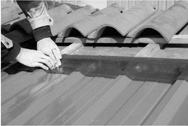
Fig. 24 Collez la bande Wakaflex de 14cm sur le liteau de basculement en partie haute et maroufler la de sorte qu'elle adhère de façon étanche en continu sur les bacs InterPV.
