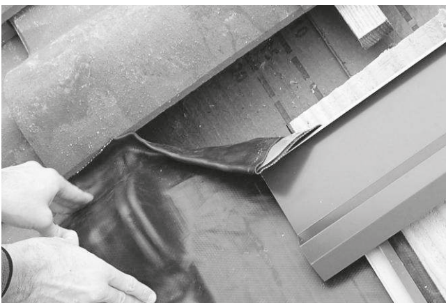
Fig. 16 Marouflez la bande souple jusqu'à ce qu'elle colle de façon continue sur les tuiles et veillez à ne pas créer de contre-pentes qui ne permettront pas l'écoulement de l'eau en bas du toit. Commencez par coller la bavette sur chaque sommet des tuiles. Le recouvrement entre deux bandes de Wakaflex doit être d'au moins 100 mm.
