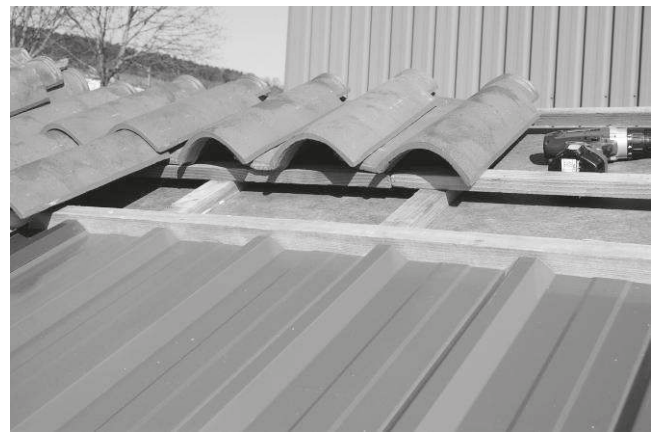
Fig. 23 En partie haute du kit, la dernière rangée de bacs acier InterPV se pose contre le liteau de basculement. Contrôlez que la partie supérieure des bacs est soutenu, par un liteau par exemple, de sorte à faciliter par la suite l'application de la bande souple d'étanchéité.
