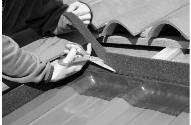
Fig. 25 Collez et découpez si besoin la mousse anti-neige sur les couloirs latéraux et la bande Wakaflex en partie haute afin qu'elle épouse au mieux la forme des tuiles.
